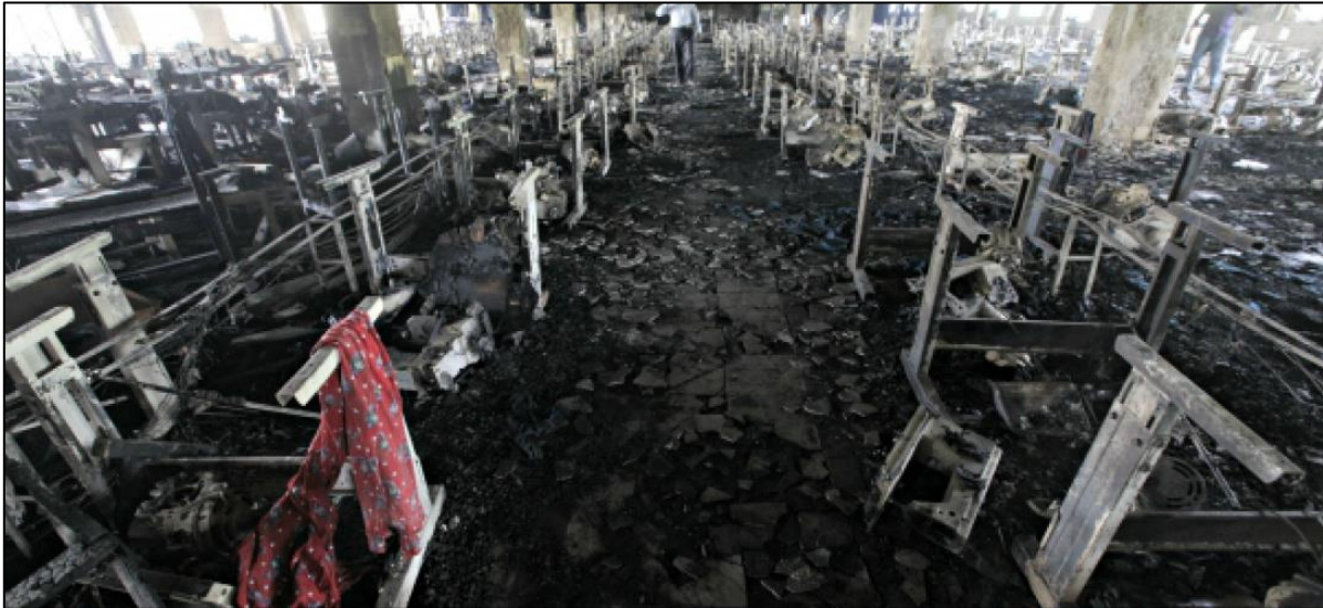
Les décombres de l'usine Tazreen Fashions à Dhaka au Bangladesh (incendie ayant entraîné 112 morts et plus de 200 blessés le 24 novembre 2012)
